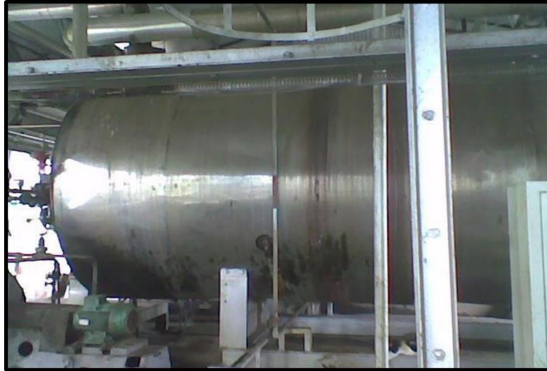
Gambar 4. Drum Boiler dalam Kondisi Bagus
