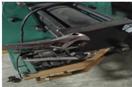
Gambar 9 Pelepasan mur baut pengunci silinder hidrolis
