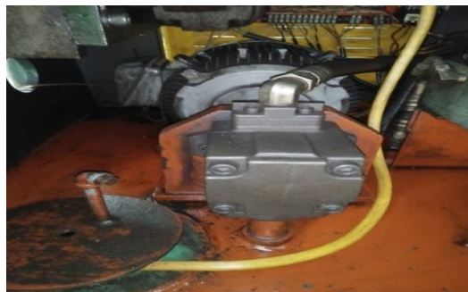
Gambar 3. Pemeriksaan oli hidrolis
