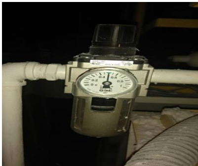
Gambar 7. Setingan regulator angin dan settingan timer
